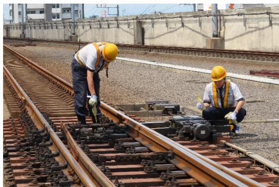
現場での点検風景
