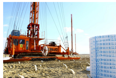
画像の説明：軟弱地盤改良の現場イメージ
