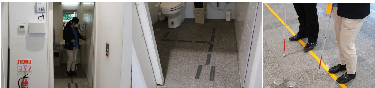
画像の説明：左からバリアフリートイレ内で「ガイドレット」の誘導を確かめる高橋選手。視覚障害者トイレ誘導ライン「ガイドレット」がバリアフリートイレ内に10本設置されている。視覚障害者歩行テープ「ココテープ」を踏み、足裏の感触を確かめる山口選手と高橋選手
