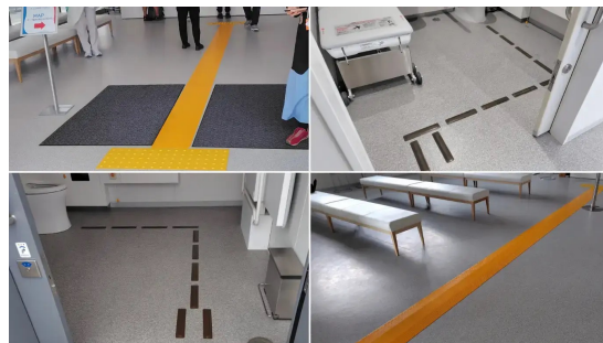
画像の説明：上段2枚の写真より、東ゲート施設に設置された歩導くんガイドウェイとガイドレット。下段2枚の写真より、西ゲート施設に設置された歩導くんガイドウェイとガイドレット
