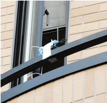
▲施設ベランダ部分に受信機を設置。
