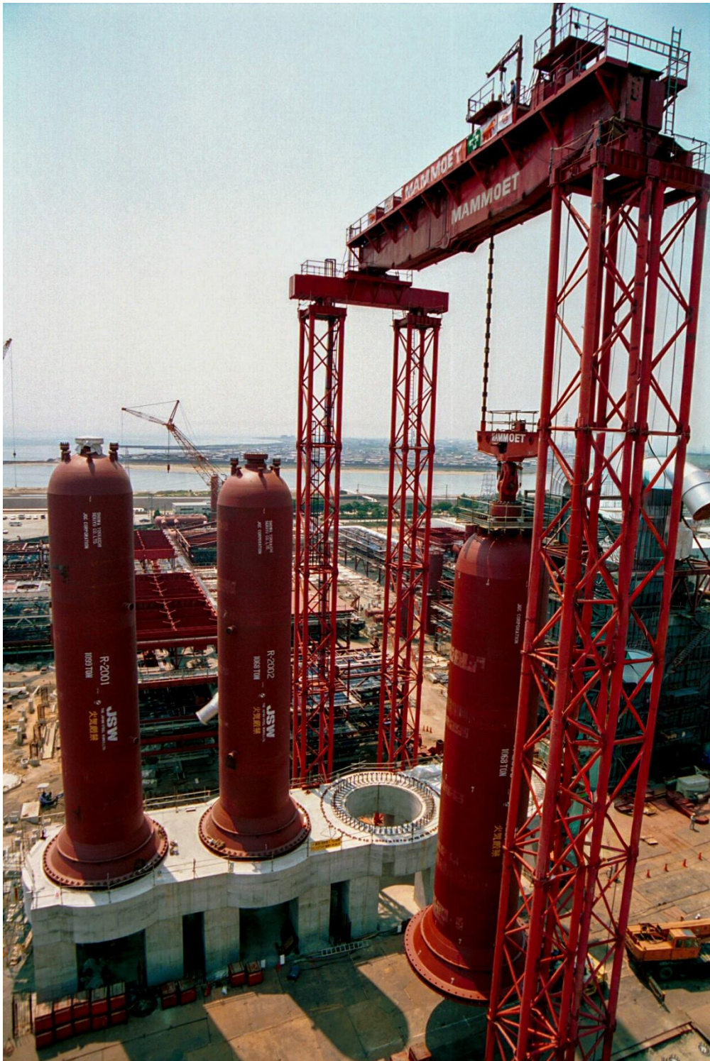
写真 2 : 1995 年、昭和四日市石油製油所増設工事におけるガントリー吊上げソリューション
