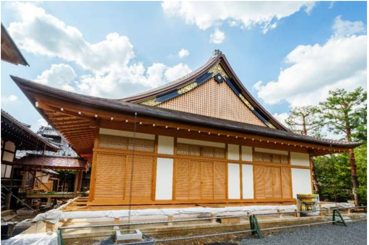
客殿外観(完成前)
