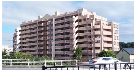
被災したマンション外観
