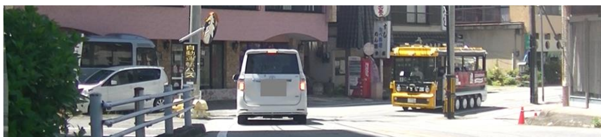
■ 「ICT LED 電光掲示板」 設置の様子 (2022 年栃木県内の実証実験において)
