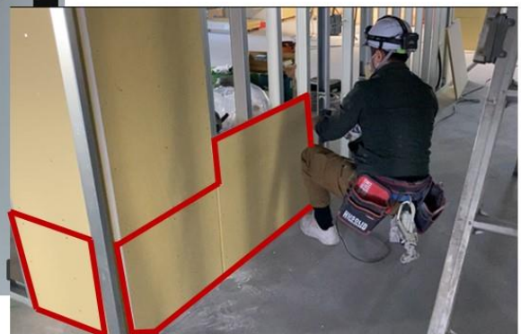
【実際の施工状況】
