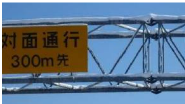
■左（NHルーフ設置なし）：道路標識柱の上部に着雪あり、右（NHルーフ設置あり）：着雪が限定的
