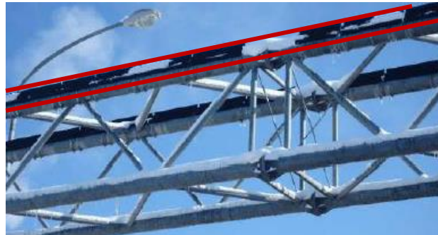
■左（NHルーフ設置なし）：道路標識柱の上部に着雪あり、右（NHルーフ設置あり）：着雪が限定的
