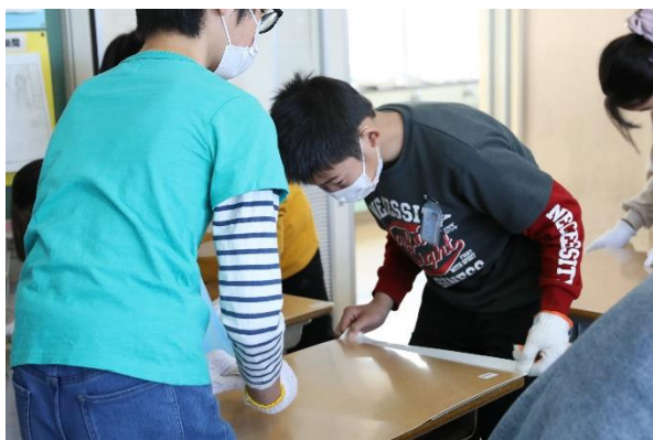
▲埼玉県久喜市の小学校での天板改修の様子
