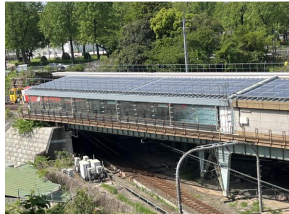
丸ノ内線 四ツ谷こ線橋
