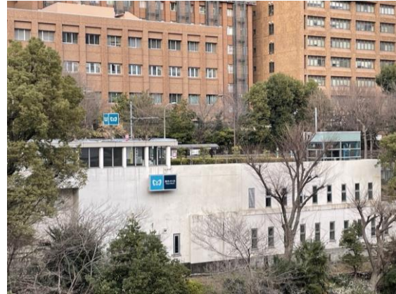
丸ノ内線 御茶ノ水駅出入口上家
