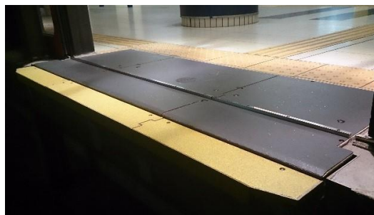
可動ステップの設置
