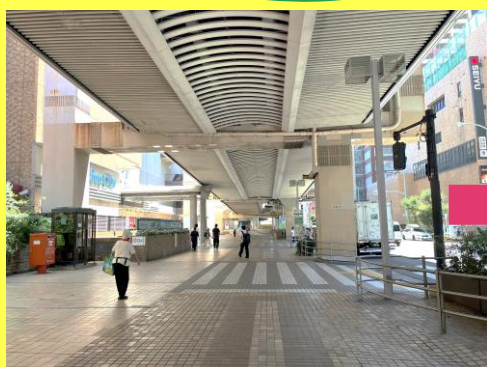
普段の高架下通路の様子
