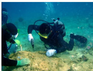
①岩盤に穴を開けます。
