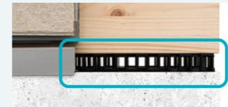
清掃方法としては、農業用噴霧器や水道ホースで床下空間の内側から換気スリット部分に水を噴霧し、泥を排出します。水圧の強い高圧洗浄機は、狭い床下空間での取り扱いが難しく危険を伴うためおすすめしません。床下空間からキソパッキンの換気スリットを見て、屋外の明るさが確認できるようになれば、換気スリット内部の泥などが排出されたと判断できます。
