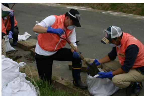
側溝のへどろを清掃する当社社員（東松島市）
