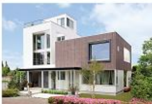
新築住宅の建築事業
