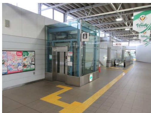
《① 飛田給駅現行エレベーター》
