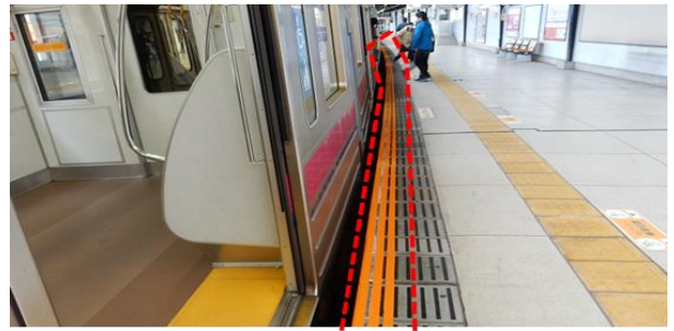
《注意喚起ライン（施工例：京王稻田堤駅）》
