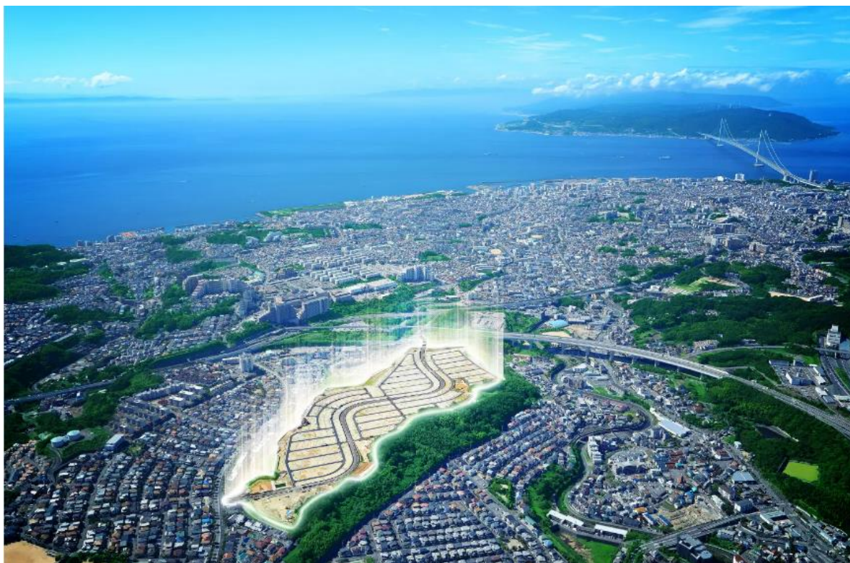
『ウインズタウン神戸みずき台』造成地全景 空撮
