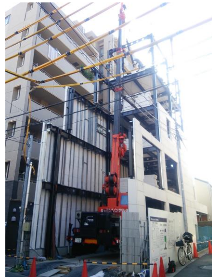
無足場工法で施工中の現場
