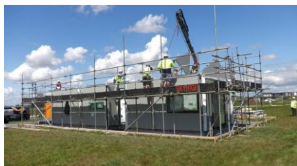
建築中の様子
