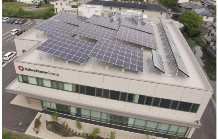
【大和ハウス佐賀ビル】
