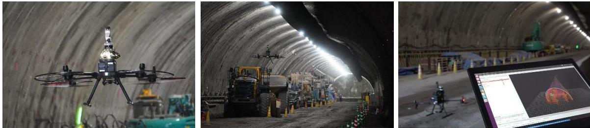
図1 トンネル坑内のドローン自律飛行
