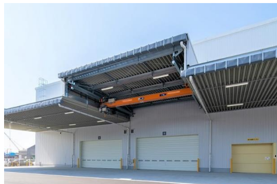
【東側トラックバース 天井クレーン (低床)】
