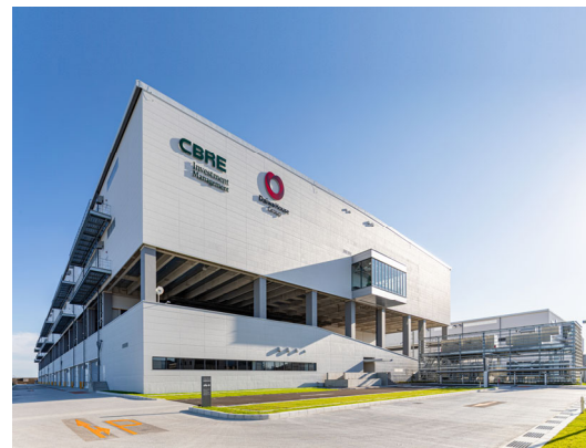
【「神戸長田物流センター 東棟」外観】
