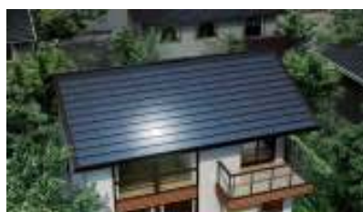
太陽光発電システム
