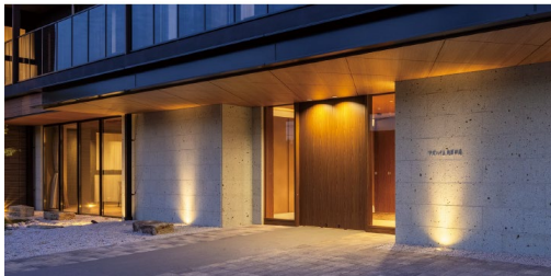
【擁壁の大谷石を用いた中庭】
