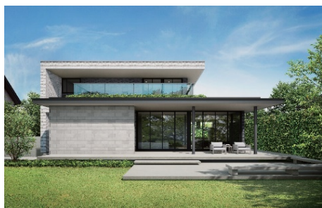
戸建注文住宅外観（イメージ）
