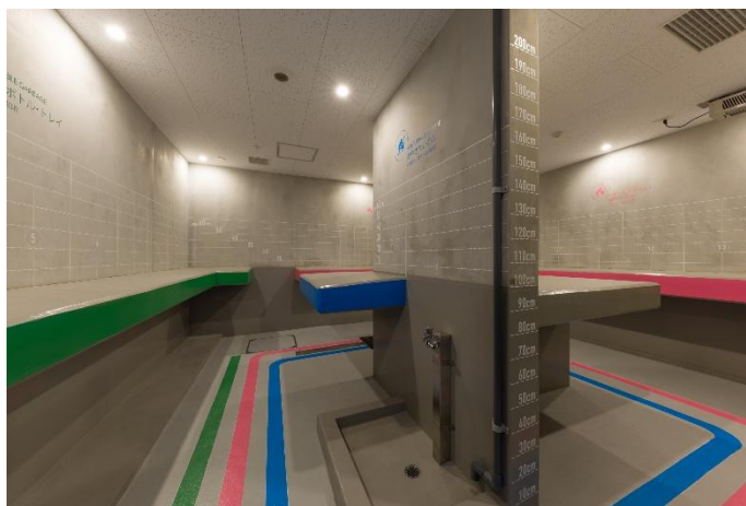
『イニシア日暮里』クリーンステーション
