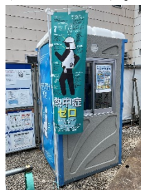
施工現場に設置した身体冷却設備
