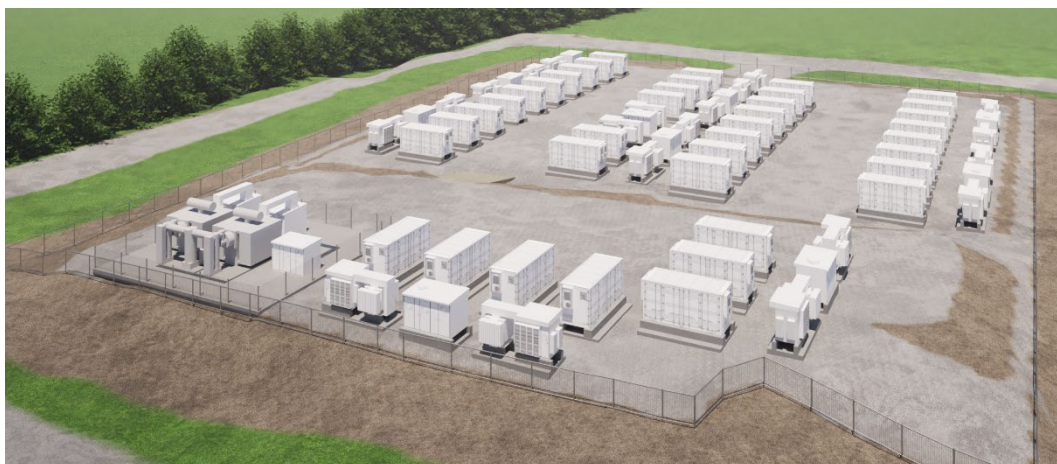
【特別高圧系統用蓄電所 完成イメージ】
