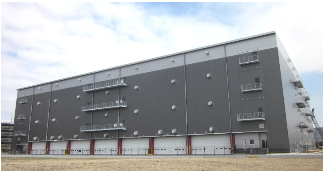
「(仮称) ノスキャップ工法」を使用した物流施設
