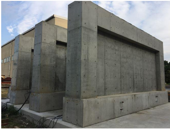
実大壁試験体
