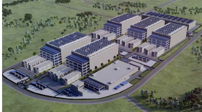
【「Air Trunk TOK1 (エア トランク トウキョウ ワン) データセンター」全体イメージ】
