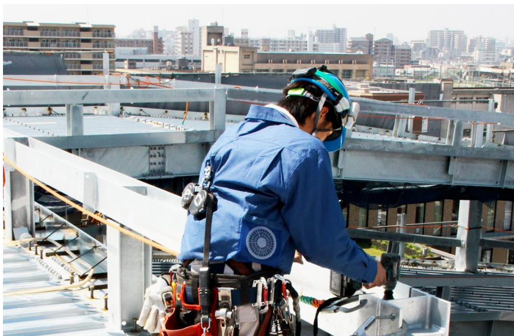
空調作業服を着用して作業する様子(写真は作業員用フルハーネス ※2 仕様)
