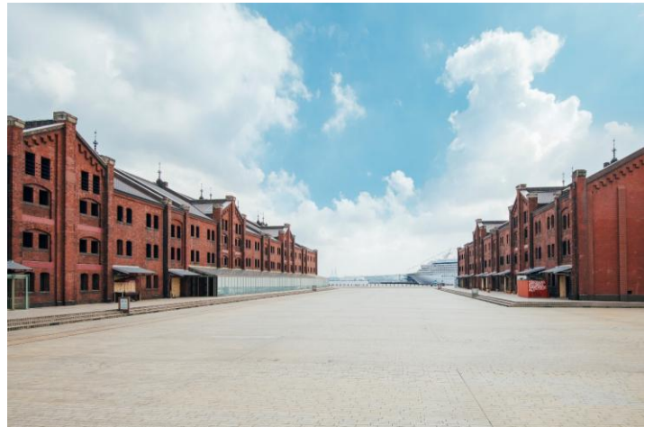
横浜赤レンガ倉庫 外観
