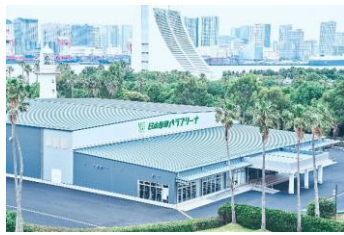
パラスポーツ専用体育館 「日本財団パラアリーナ」(東京都品川区)
