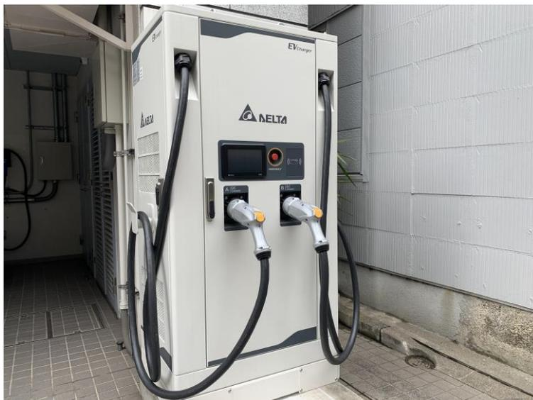
新開発の従量課金システムが搭載された EV 用 DC 急速充電器
