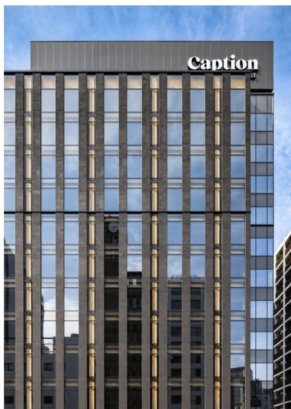
木造柱・梁が外部から見通せる 外観デザイン
