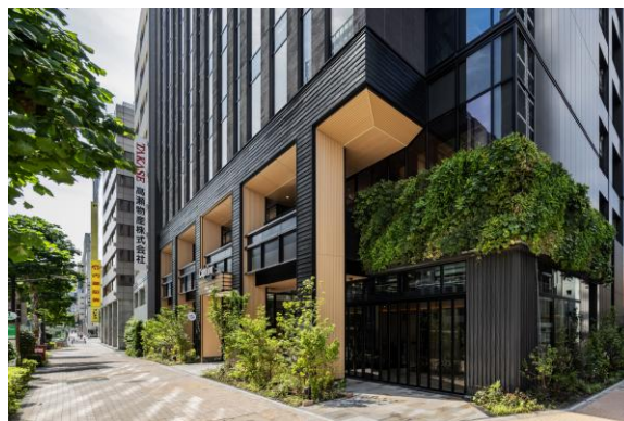
低層部の外装には焼杉や壁面緑化を採用
