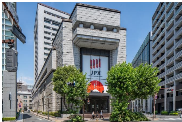
東京証券取引所ビル（奥：本館、手前：市場館）
