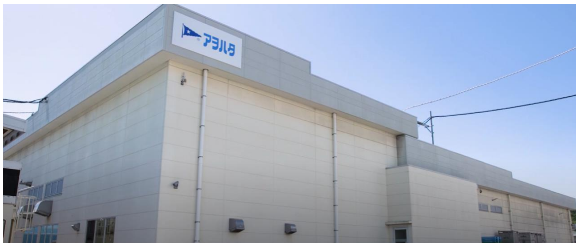
アヲハタ株式会社 ジャム工場の外観
