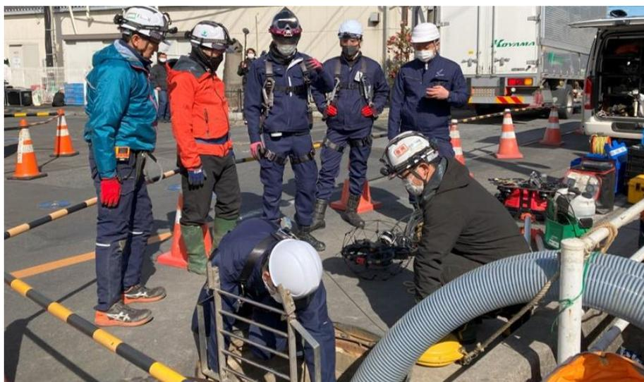
2025年1月28日(火)に発生した埼玉県八潮市道路陥没事故を受け、流域下水管の状況確認が急務となっています。本調査では、GPSが届かない環境でも安定して飛行可能な「ELIOS 3 (Flyability 社製、本社:スイス)」を活用し、事故現場の下流約600m付近のマンホールから下水管内の状況を調査しました。内部映像とともにリアルタイムに表示される高精度3Dマップにより、調査精度の向上に貢献しました。
