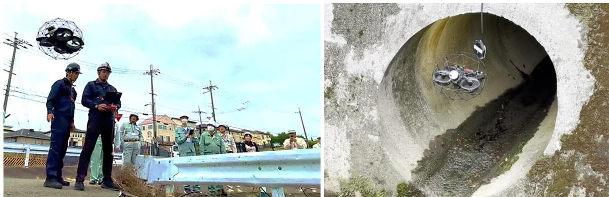
大阪府富田林市での技術検証の様子(左)と管渠に進入する ELIOS 3(右)
