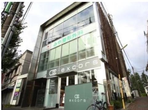
この建物の地下1階
