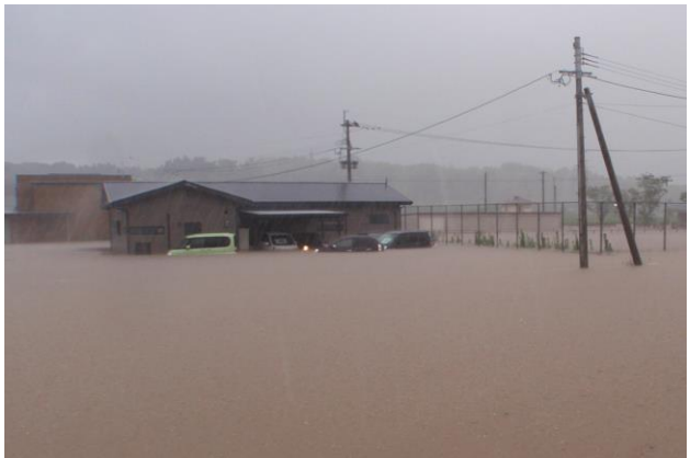
鹿児島県鹿屋市
