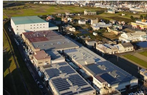
< 本社三重工場の屋根に設置した太陽光発電システム >
