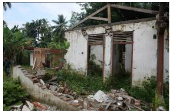
地震で全壊したトイレの跡地(右前)と建設中のトイレ(左奥) (インドネシア/パダン・パリアマン県)
